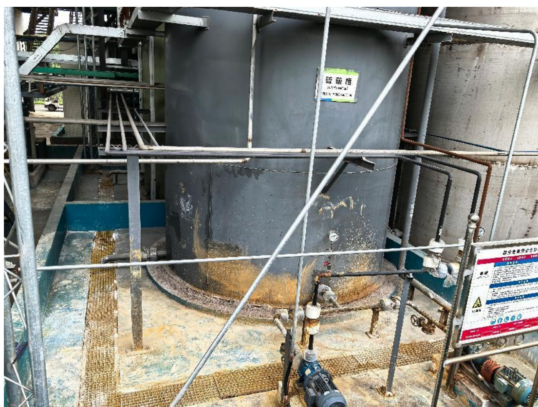
围堰及围堰内收集沟
